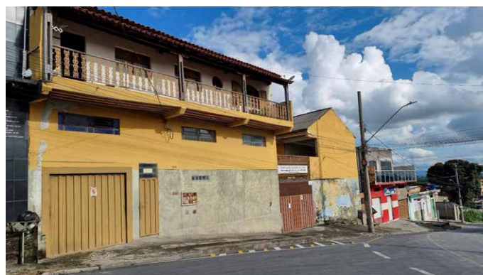
Maison communautaire à Nova Contagem
